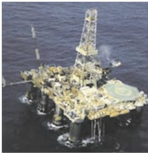
FIGURA 1.2 – P-12 - PLATAFORMA FLUTUANTE DE PRODUÇÃO
