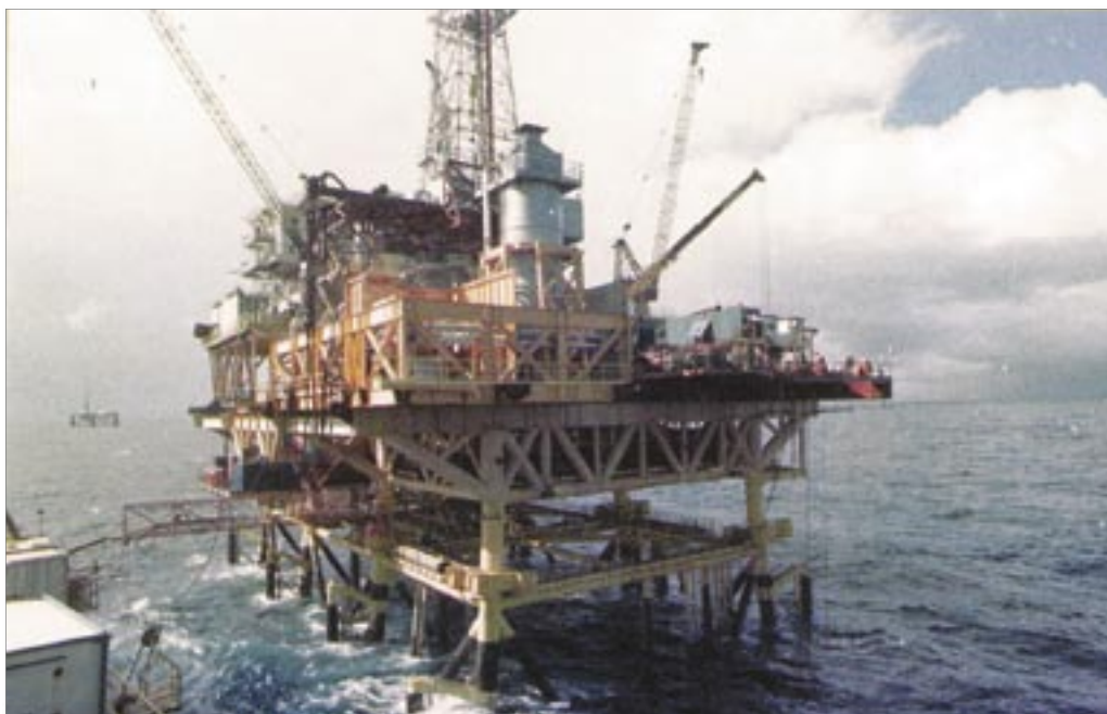
FIGURA 5.41 – A CONSTRUÇÃO DA PLATAFORMA FIXA DE GAROUPA, PRIMEIRA GRANDE ESTRUTURA INSTALADA NA BACIA DE CAMPOS, FOI REALIZADA EM SÃO ROQUE DO PARAGUASSÚ (BA)
