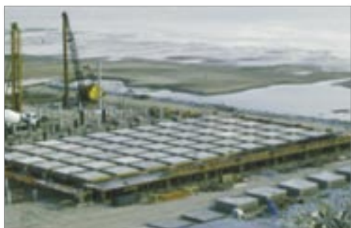
FIGURA 4.67 – OBRAS EM TERMINAL PORTUÁRIO DE PARANAGUÁ
