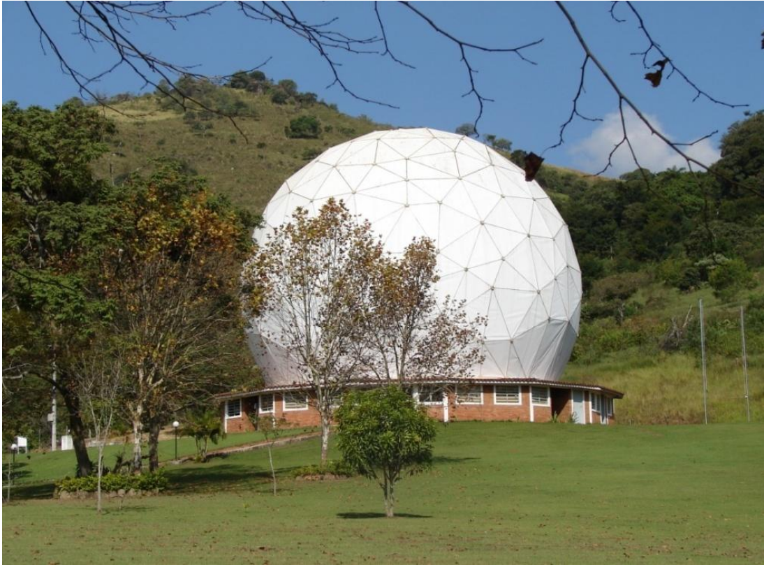
Figura 2.7. Rádio-observatório de Itapetinga, onde se vê a redoma protetora, com 20 metros de diâmetro. Crédito da imagem: Rafael Milloni Santucci.
