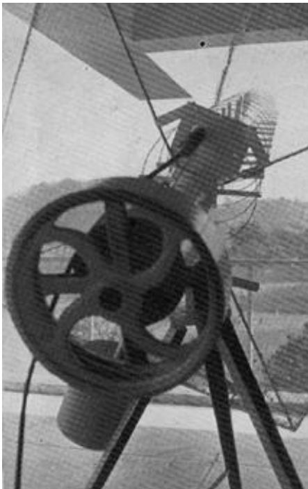
Figura 2.5. Antena helicoidal de 13 espiras do radiotelescópio instalado no Ibirapuera em 1961. Crédito da imagem: Irineu G. Varella.
