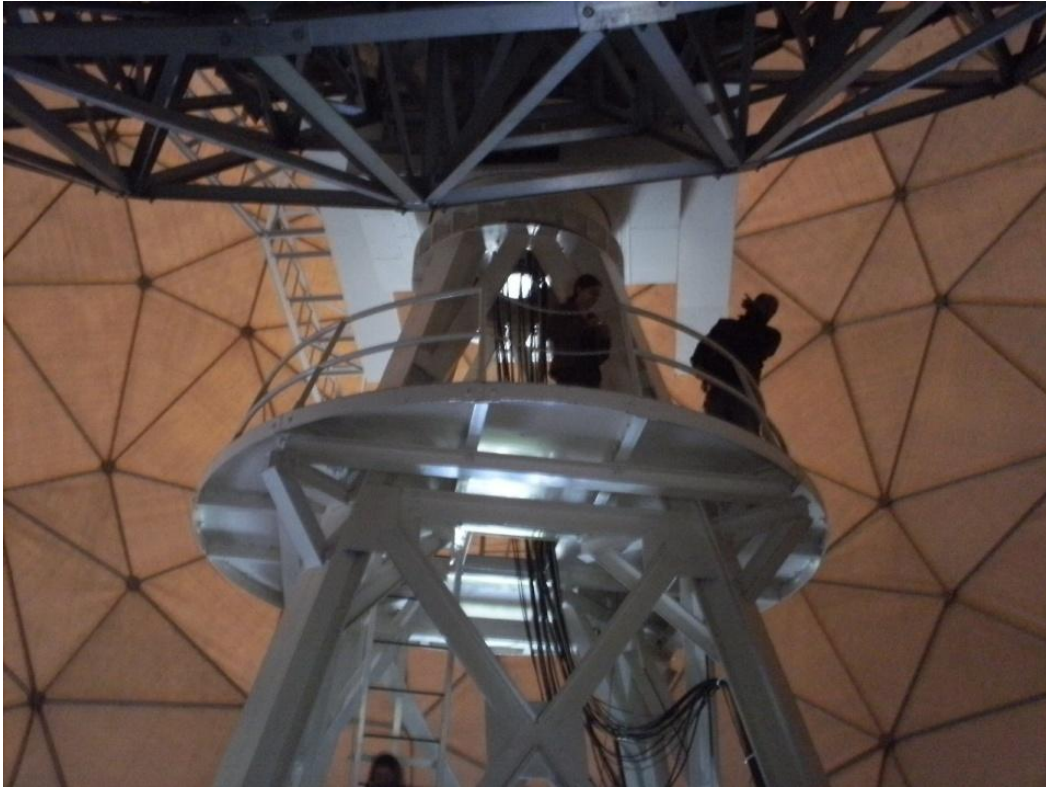
Figura 2.6. Montagem que sustenta a antena de 13,7 metros de Itapetinga. Ao redor, vê-se a estrutura da redoma protetora.
