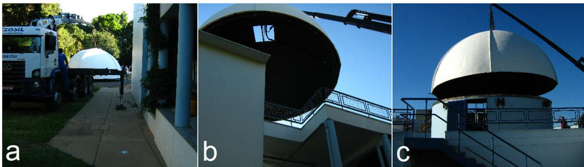
Figura 4: colocação da nova cúpula. Cúpula sendo erguida de seu lugar de montagem, no estacionamento (a); cúpula elevada até o patamar superior do prédio (b); cúpula prestes a encaixar nos trilhos da alvenaria do pavilhão do refrator Grubb (c).
