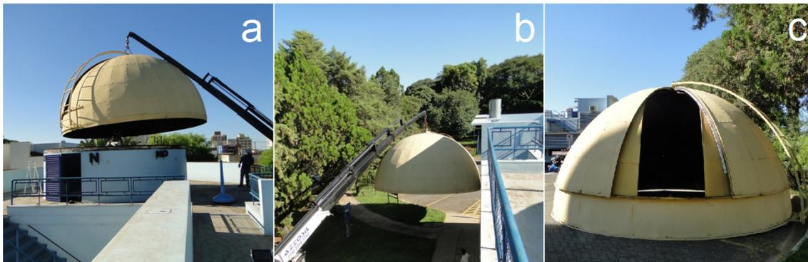
Figura 1: retirada da cúpula antiga por meio de guindaste. A cúpula de 1,5 toneladas é erguida acima do pavilhão(a), em seguida é baixada pela área do Jardim do Céu na Terra (b), e colocada na rotatória, previamente interditada(c).
