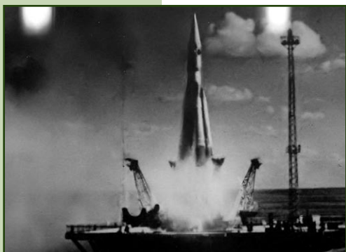
Figura 4.9. O R-7, primeiro lançador de satélites do mundo.
