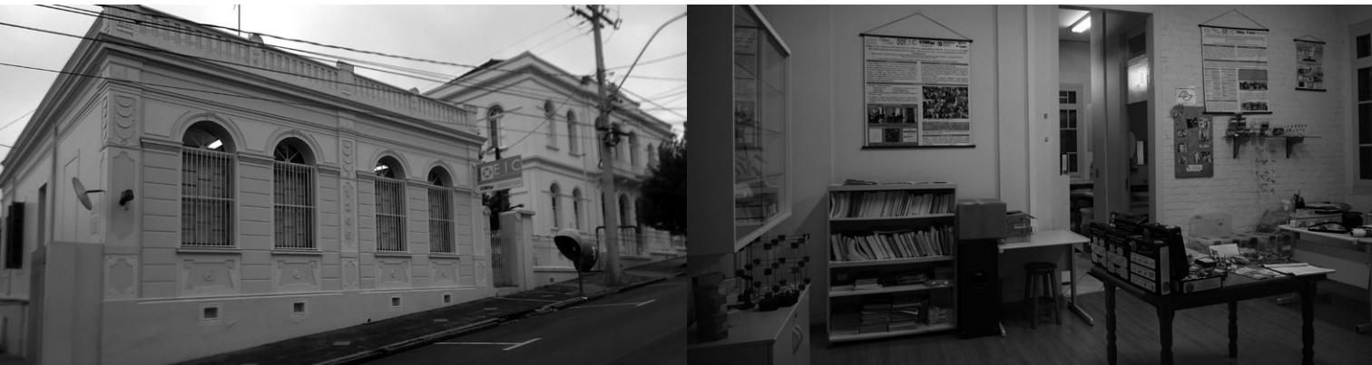
Fachada do prédio e espaço interno do EIC
